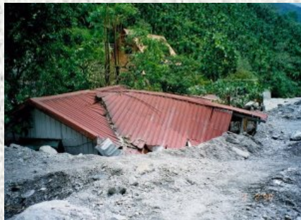
水土保持工程：土石流災害防治
