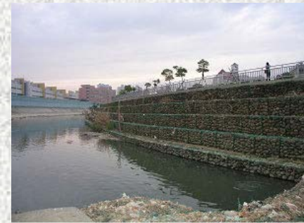
河川工程：生態護岸
